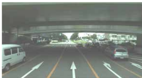
駅西新都心ゾーンの高架(36キロ付近)
