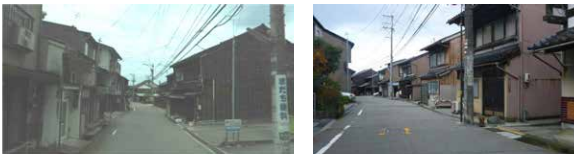
民家が連担する幅員の狭い道路
