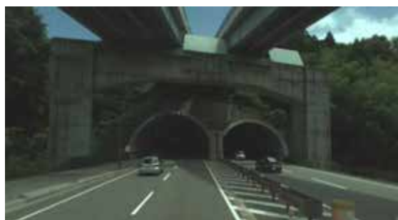
崎浦涌波トンネル(入口部)
