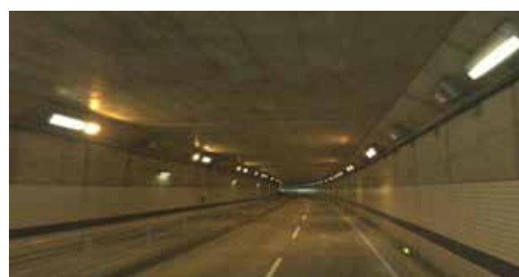
野田トンネル(内部)
